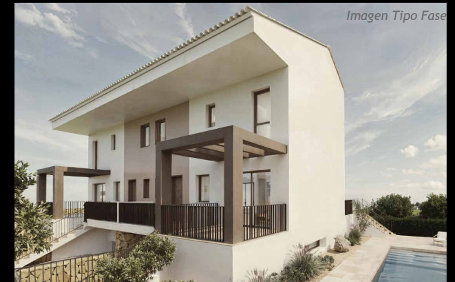
Fase 09 | Vivienda 8B
