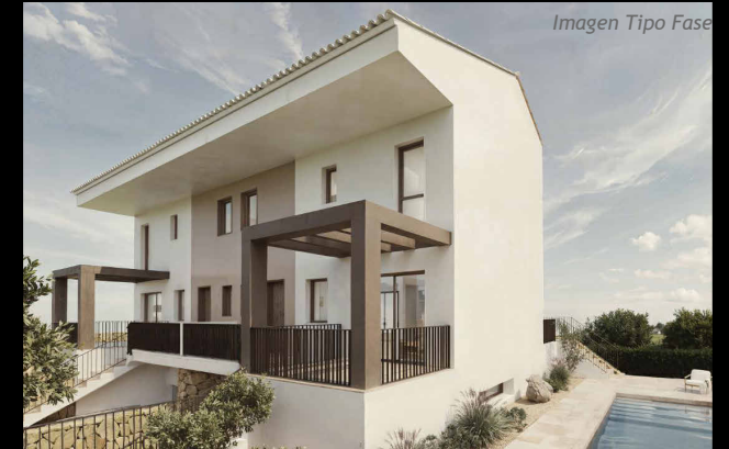
Fase 09 | Vivienda 8B
