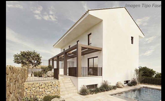
Fase 10 | Vivienda 9A
